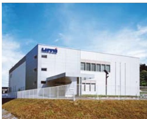
株式会社ユー・エム・アイ 西日本支社・九州工場外観
