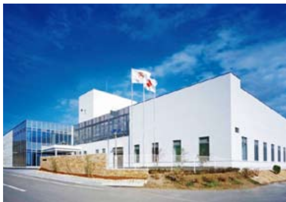
マルハチ・テクノロジー外観
