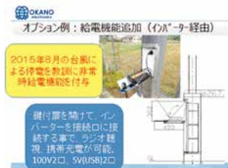
薩摩川内市避難所詰所 停電時給電機能 説明例
