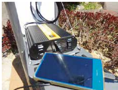
薩摩川内市避難所詰所 停電時給電機能 使用例
