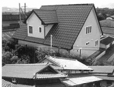
＜FRP製瓦で施工した屋根＞
