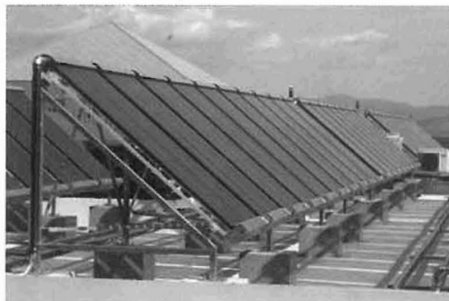
【真空管ソーラーシステムの設置例】
